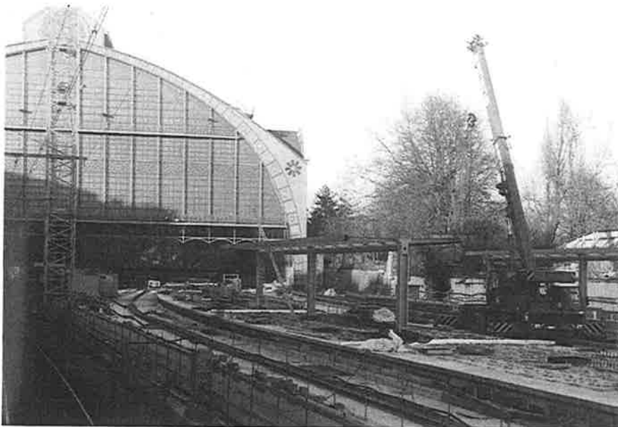
Antwerpen-Centraal, 22 december 2000. Het geraamte voor de overdekte perrons is aangebracht. Foto : Alain Janmart.
